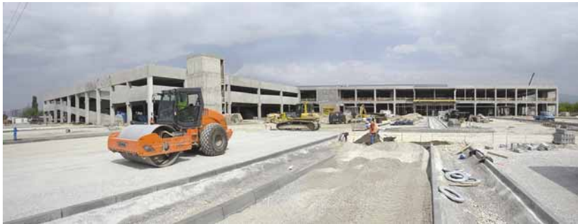
City Center One u izgradnji
